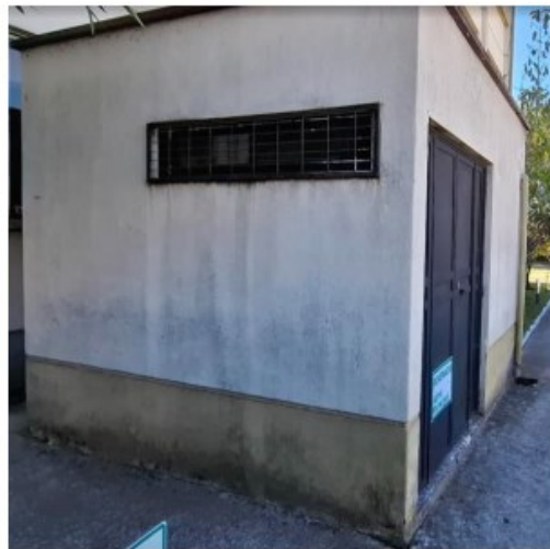
Protecciones metálicas de ventanas, pasamanos, puertas metálicas.
