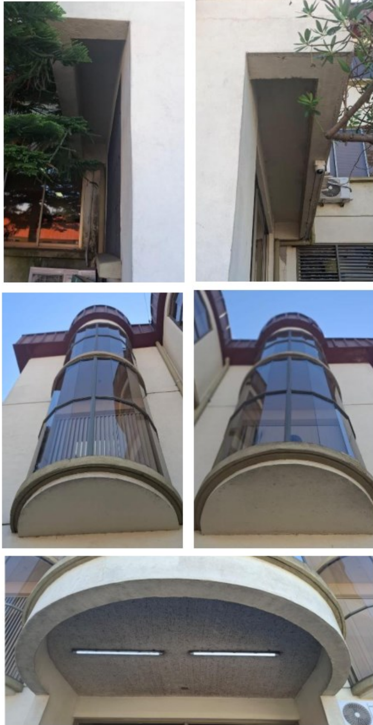
Cielos bajo losas existentes fachada sur.
