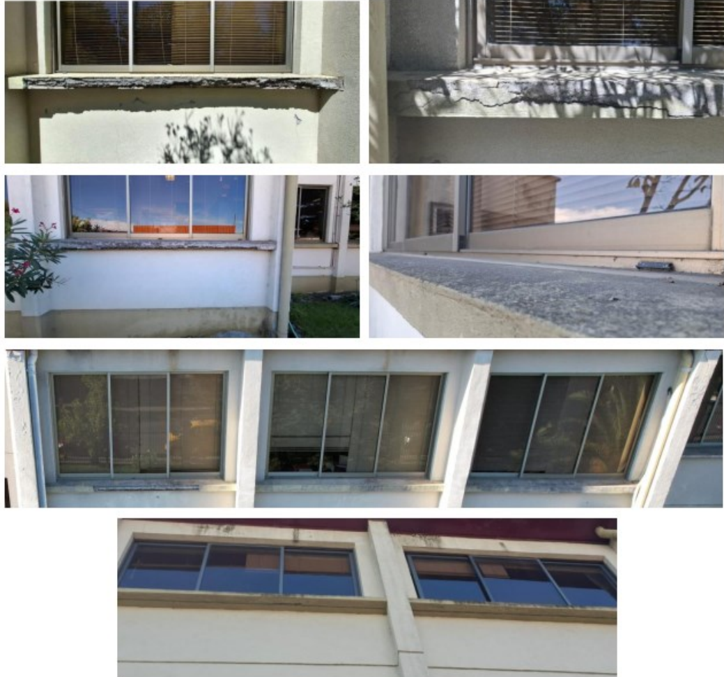
Alféizares de hormigón existentes.
